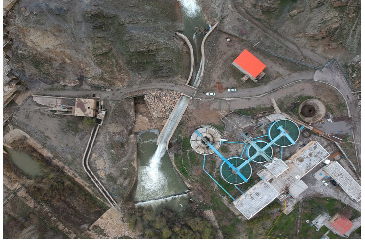
تصفیه خانه سد اکباتان
