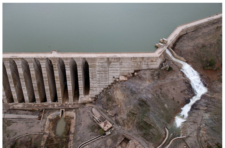
سر ریز سد اکباتان در بها ۱۳۹۹
